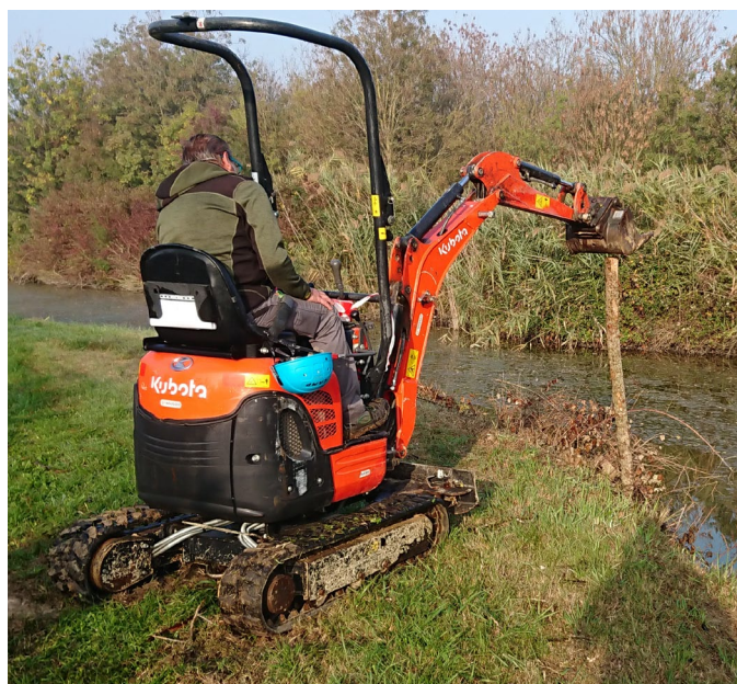
Infissione dei pali con escavatore.
