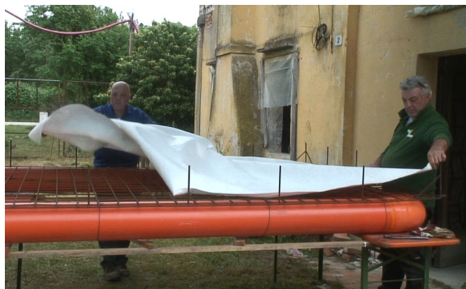
Applicazione del geotessuto
