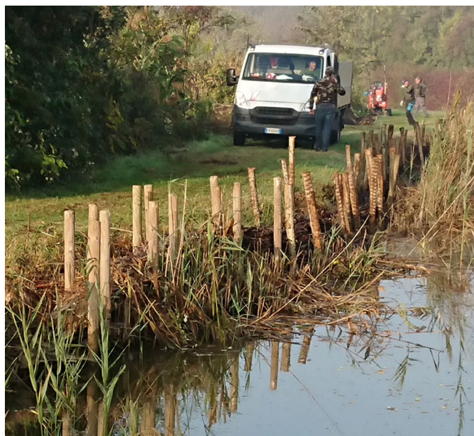
Argine del canale con fascine posate.
